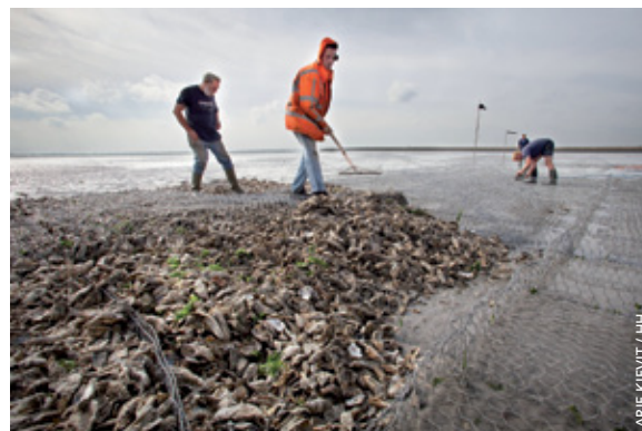
▼ Rellenando gaviones con conchas de ostras
