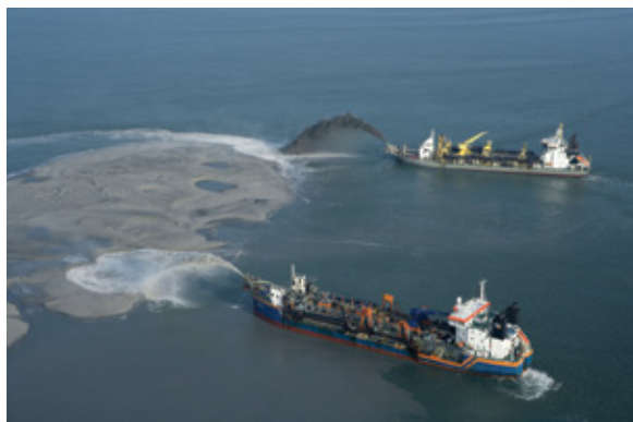
▼ Regeneración de costa vertiendo por cañón
