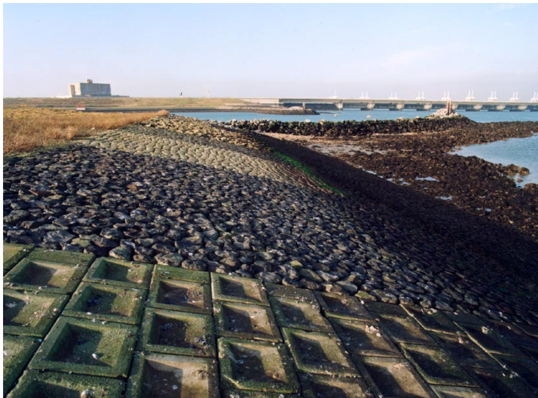
In het natuurexperiment dijktoen op Neeltje Jans wordt onderzocht welke invloed het dijkbedekingsmateriaal heeft op de begroeiing
