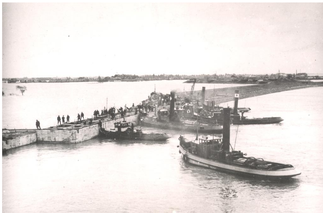
Mei 1953: sluting van een dijkgat nabij Kruiningen met behulp van caissons
