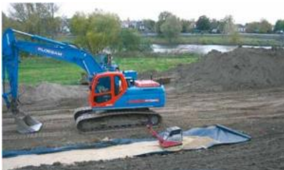
Figuur 4.7: Aanbrengen van kleilaag om de kwelweglengte te vergroten (bron: EcoShape website)
