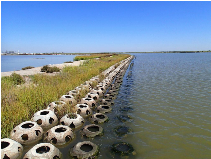
Figuur 12.2: Voorbeeld van ecovriendelijke harde bekleding (Ecoshape website)
