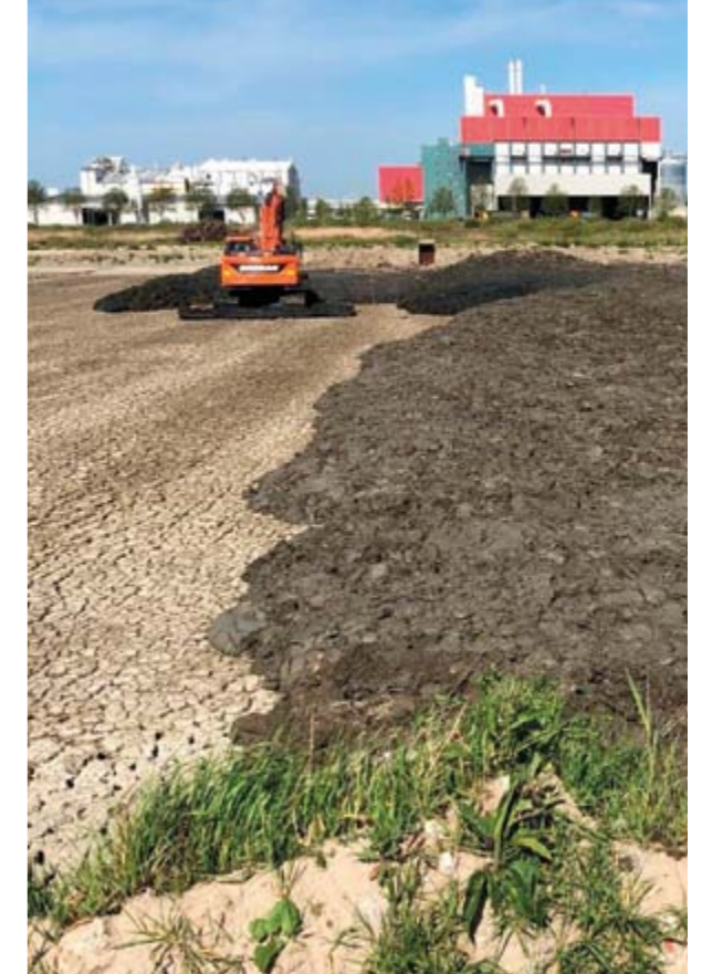
Om de rijping van het slib te bevorderen wordt de sliblaag met een kraan omgezet
