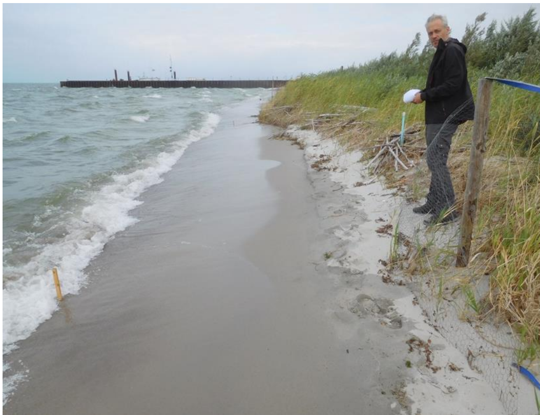
Figuur 2.8 Pilot Houtribdijk. Restanten van een wilgentakkendam, aangelegd om erosie van de oeverzone te voorkomen, liggen aangespoeld in de sterk afgekalvde oever. Een van de vegetatieproefvlakken (gemarkeerd met houten paaltje) ligt nu in de waterlijn (foto: Rienk-Jan Bijlsma, september 2017).
