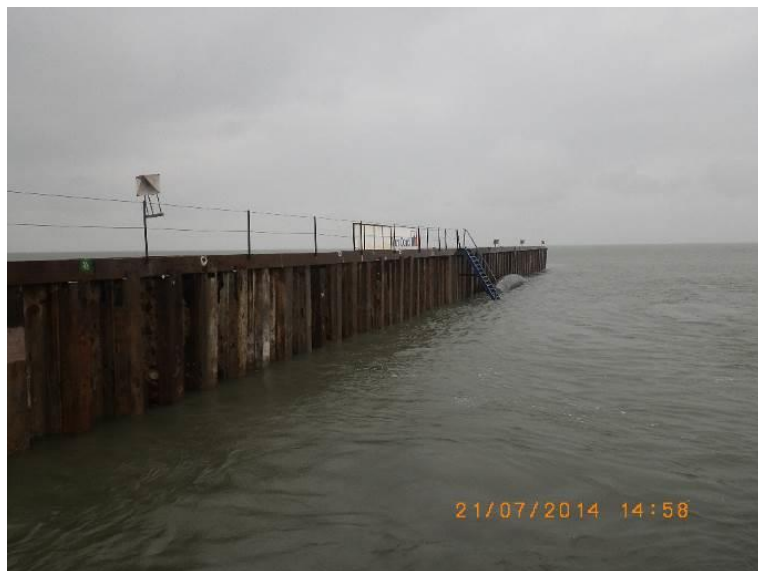
Figuur 5 Damwand gereed.
