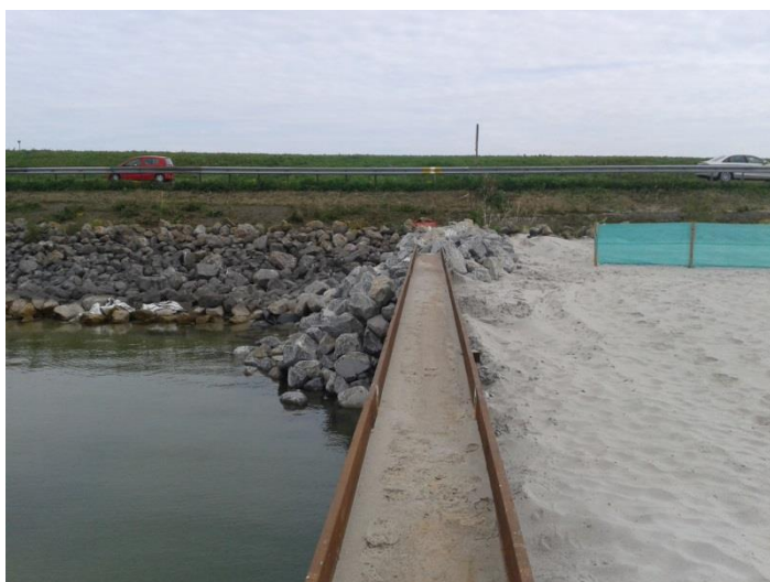
Figuur 11 Begin stuifscherm naast damwand.
