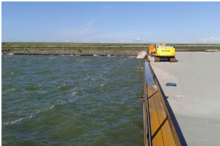
Figuur 4 Aanbrengen gording op damwand.
