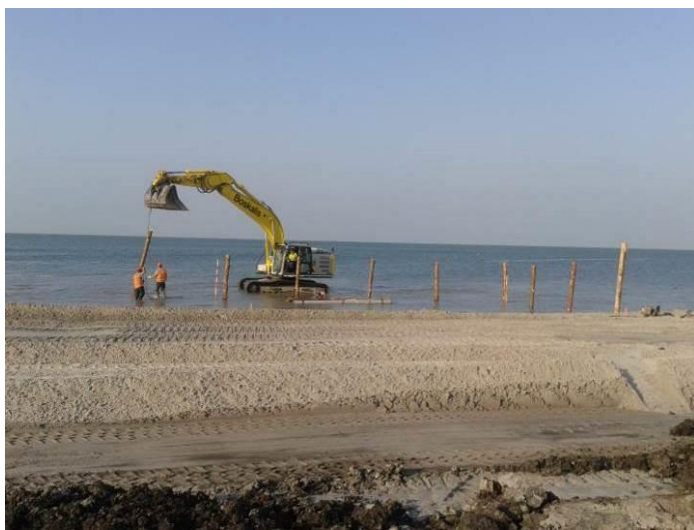
Figuur 13 Aanbrengen palen t.b.v. rijsmatconstructie.
