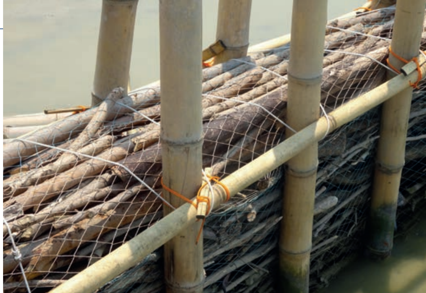
Close-up van de dam, met de dikke bamboepalen en de takkenbossen die de golven tegenhouden.
