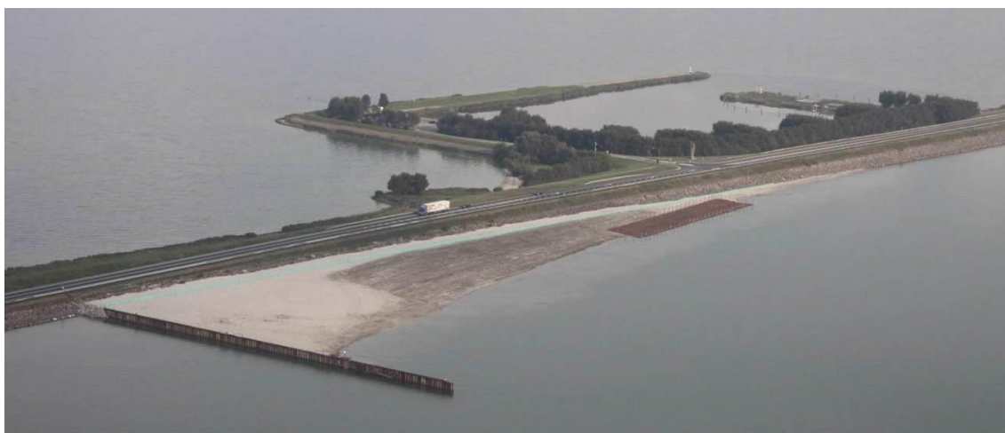
Figuur 1-1 Overzicht proefsectie langs Houtribdijk in september 2014 na afronding van aanlegfase bij aanvang monitoringsprogramma [bron: opname Mennobart van Eerden].
